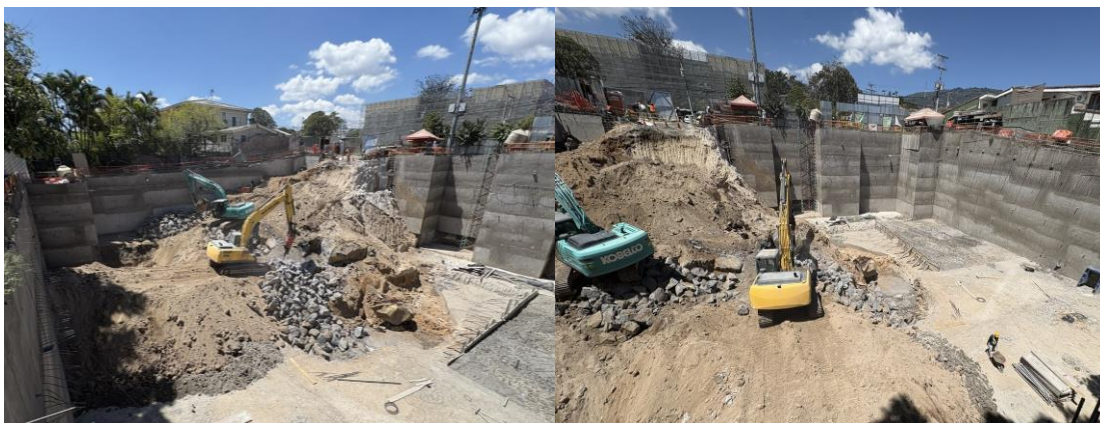
Estado actual del inmueble – Proceso de construcción
